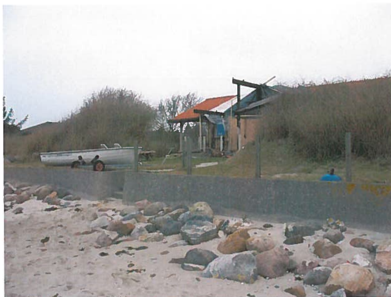
Figur 4-1: Fremrykket betonmur.
