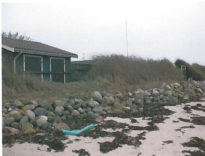
Figur 4-2: Stensætning foran diget
