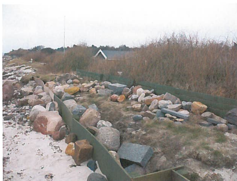
Figur 4-3: Beskyttelse med sten og plader
